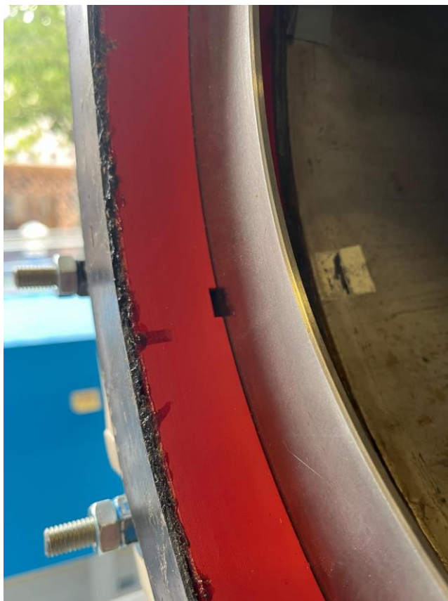
Abbildung 3-4: Aktuell verbaute Normblende.
