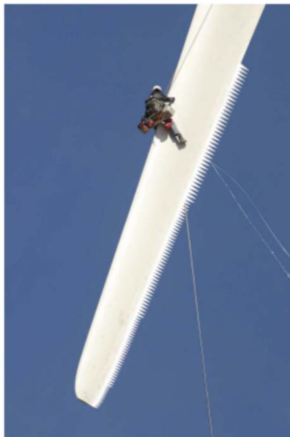
Abbildung 1: Gezackte Hinterkante an einem Rotorblatt (Oerlemans et al., 2009).
