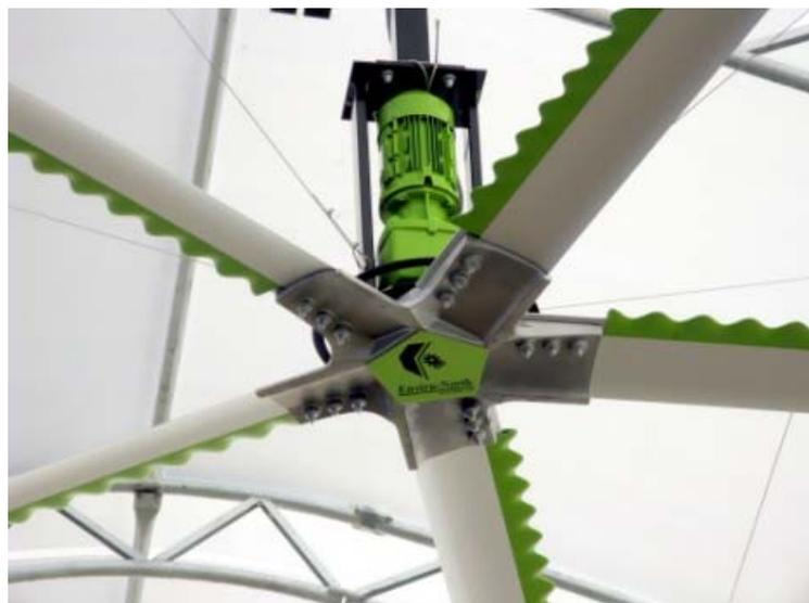
Abbildung 4: Envira-North Ultra-Air Deckenventilator mit Vorderkantenverzahnung (Envira, 2016).
