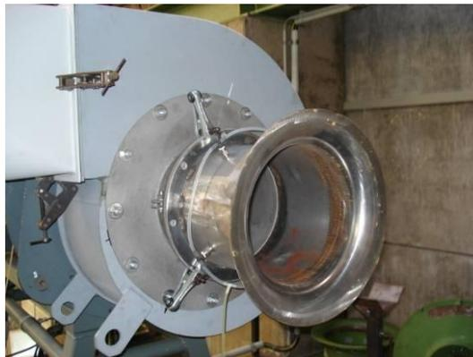
Bild 13: Einlaufdüse DN280 mit nicht überdecktem Spalt
